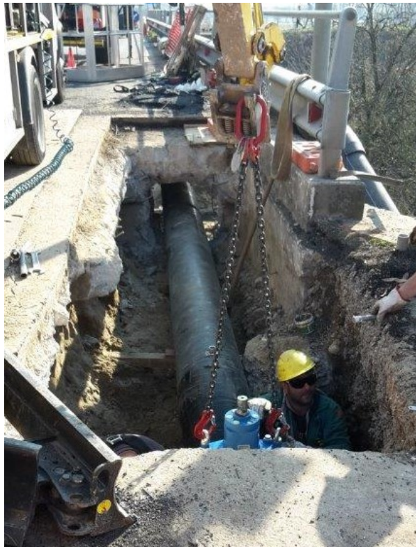
Lavori di sostituzione della condotta idrica in Via Padova SP 42 in Comune di Cartura - prog. n. 642
