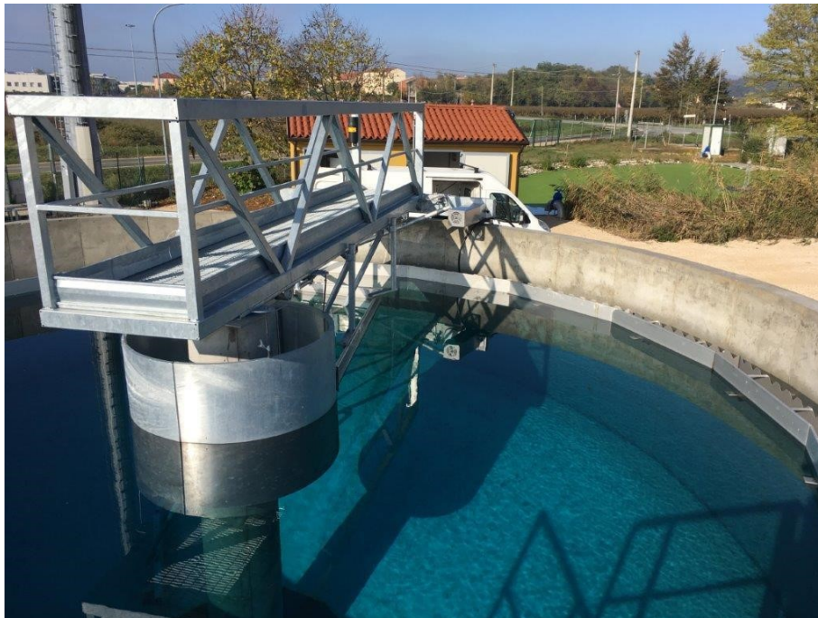
Lavori di adeguamento dell'impianto di depurazione di Alonte (VI) – prog. n. 223
